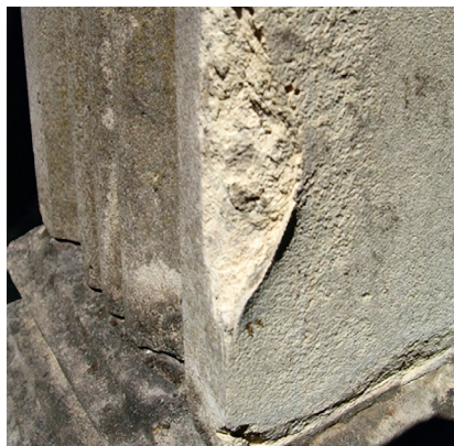
Exemple de soulèvement de la pierre à cause du nettoyage à l'eau de javel d'une tombe adjacente
