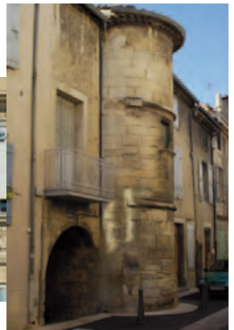
Cage d'escalier en vis en hors-d'œuvre. Donzère, Grande-Rue. © Yves Esquieu
