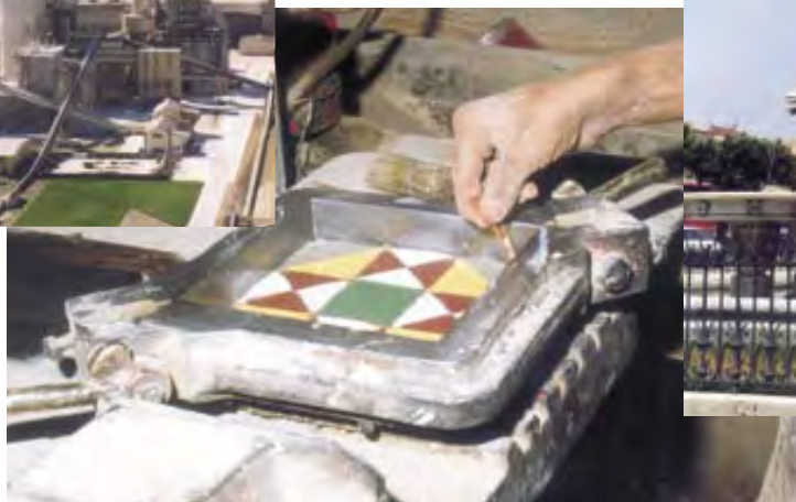
Réalisation d'un carreau de ciment, couche supérieure après retrait du diviseur. Fès, Maroc.
